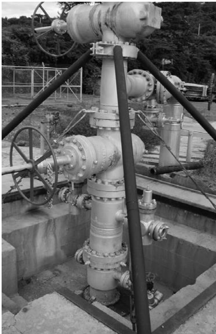
شکل (۲-۲) - شیر سرچاهی مجهز به expansion spool
